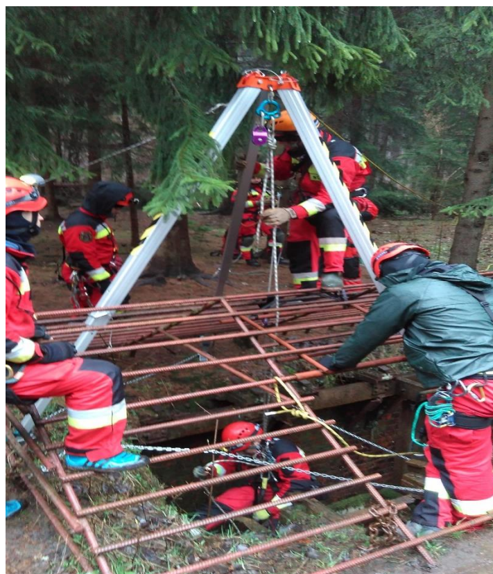
Budowa stanowiska – szymb „Luiza” – Radzimowice. (Fot. Dowódca SGRW Słupsk).
