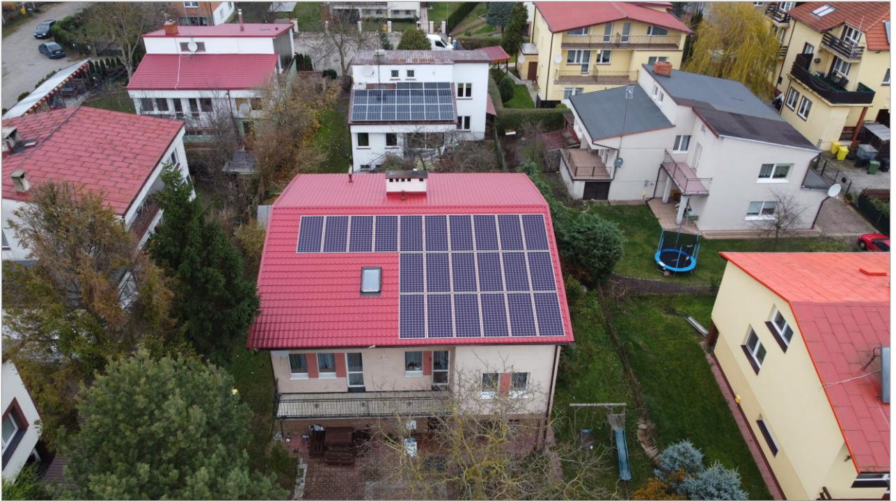
Ilustracja: Podgląd zdjęcia, 1. Powierznię modułu - Budynek 01-Powierzchnia dachu Południe
