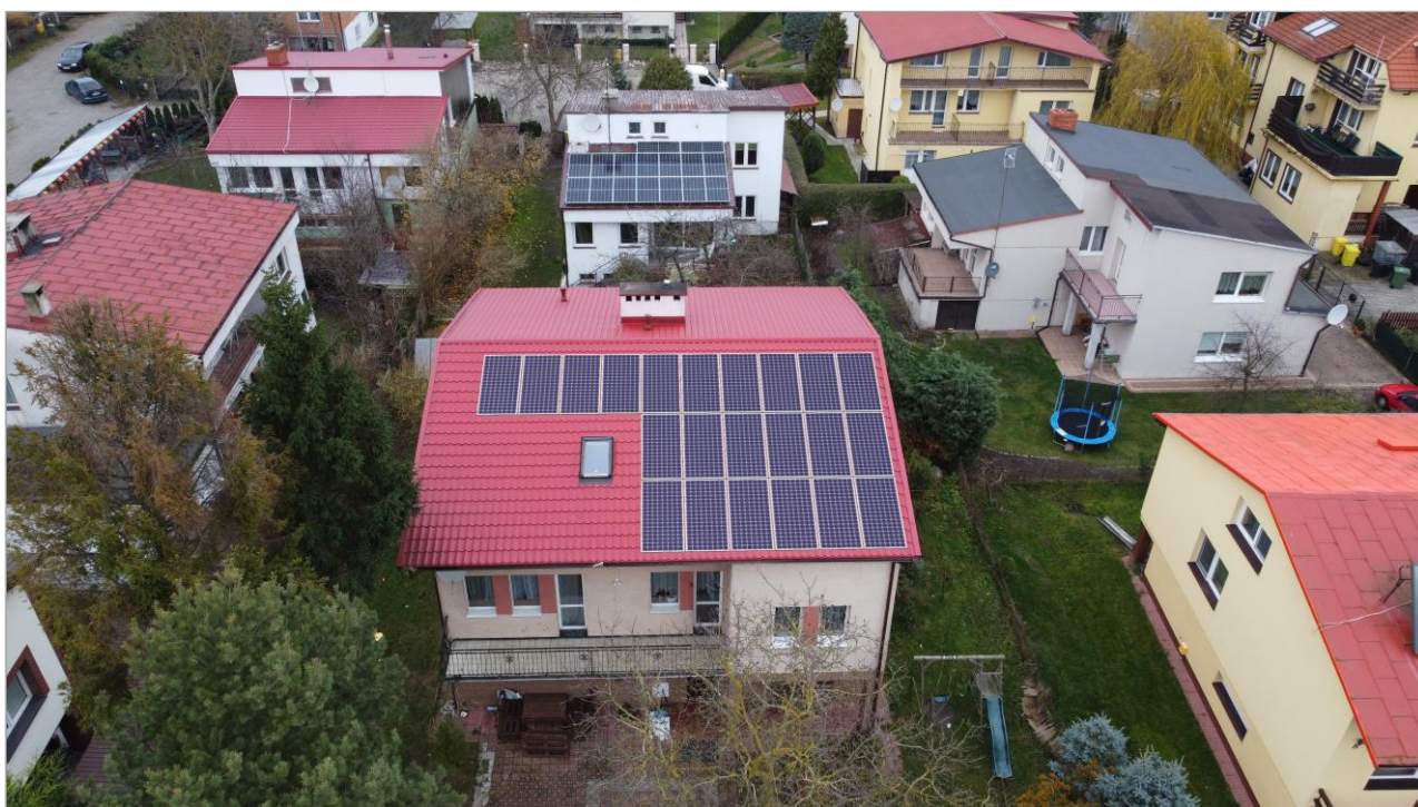
Ilustracja: Podgląd zdjęcia, 1. Powierzchnię modułu - Budynek 01-Powierzchnia dachu Południe
