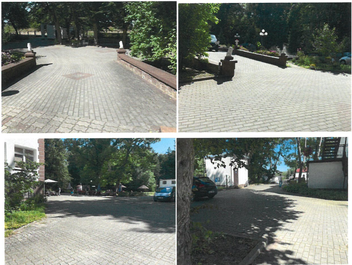
Rys. 5: Istniejący dojazd pożarowy do budynku pałacowego
