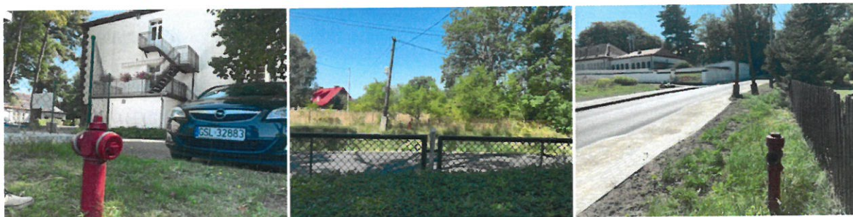
Rys. 8: Istniejące hydranty nadziemne (15 m, 35 m i 90 m od budynku)
