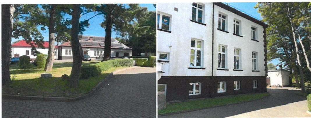
Rys. 6: Utrudnienia z zakresie wewnętrznego układu drogowego po stronie północnej budynku pałacowego
