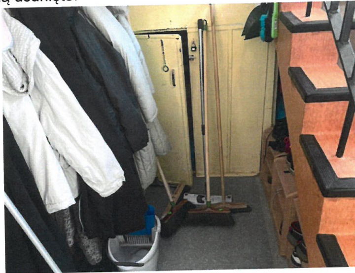
Rys.5: Istniejące zabudowy w obrębie klatki schodowej
