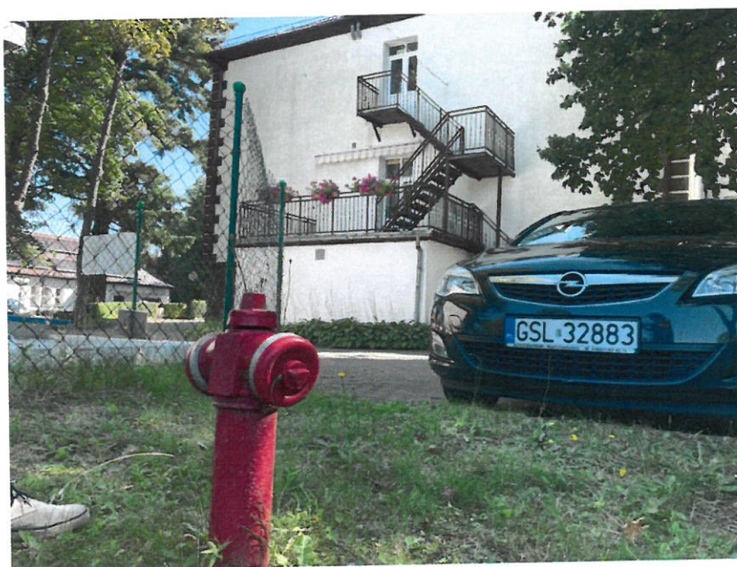
Rys. 10: Istniejący hydrant nadziemny przy budynku „Pałacyk” (122 m od budynku)
