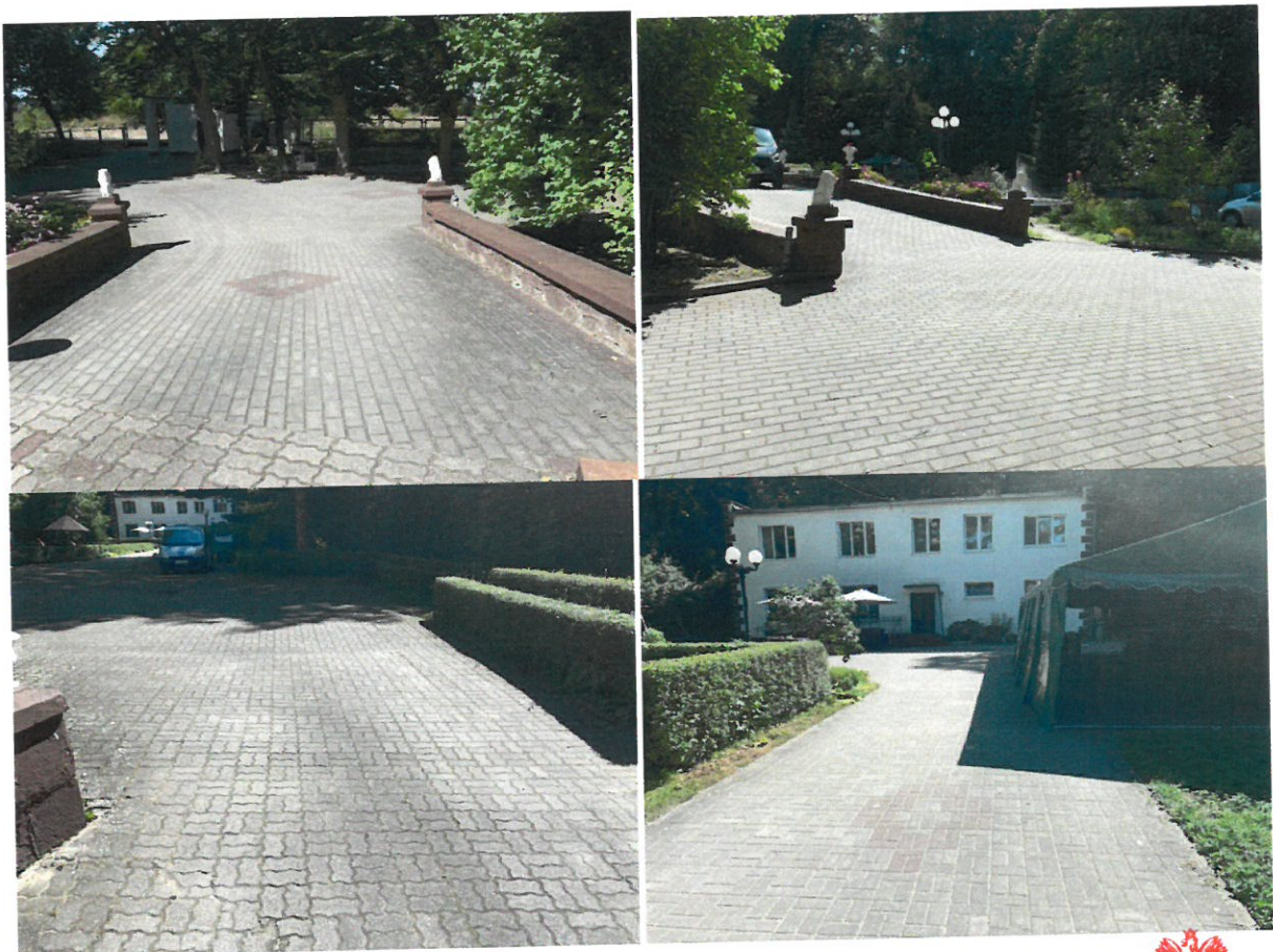
Rys. 7: Istniejący dojazd pożarowy do budynku „Rodzinka”
