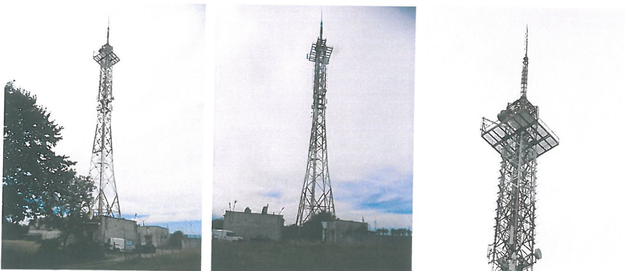
Widok obiektu wraz z zainstalowanym zespołem antenowym
