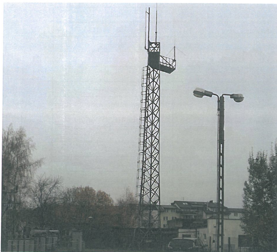
Fot. 1. Widok wieży stacji TETRA - Ustka
