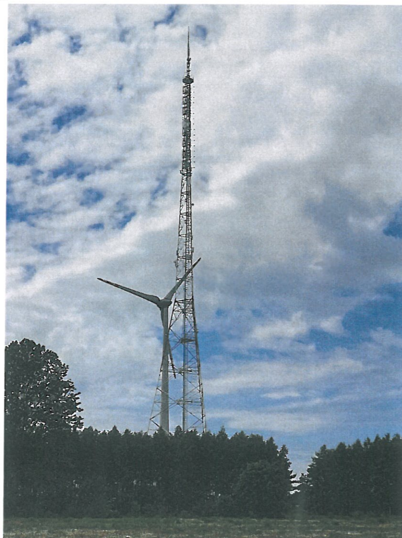
Zdjęcie 1 Badany obiekt
