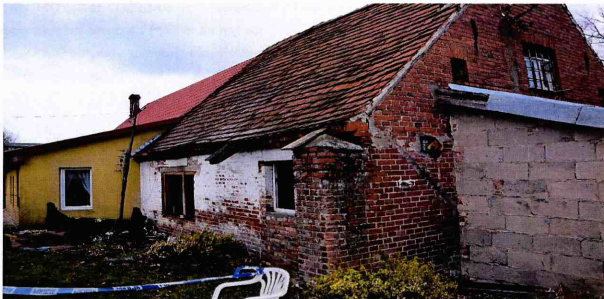
Pożar budynku mieszkalnego w Szczypkowicach (Fot. st. ogn. Rajmund Dargas)
